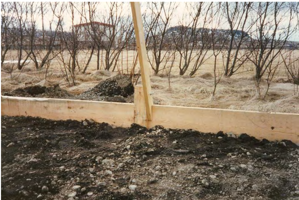
Gróðurhús fyrir plastdúk – uppsetning. Breidd 5,6 m.
