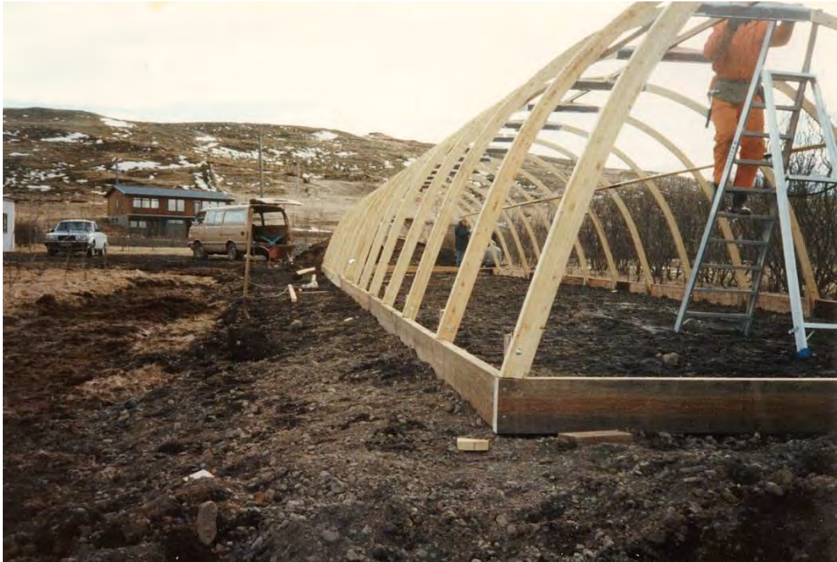
Gróðurhús fyrir plastdúk – uppsetning. Breidd 5,6 m.
